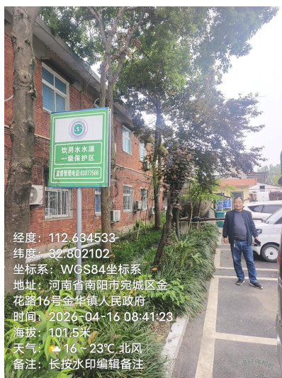
金华镇自来水厂取水口
