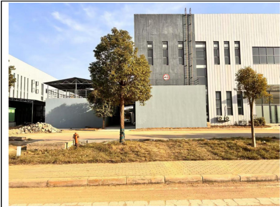
污水站西侧环境现状
