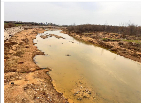
纳污河流-三夹河现状照片
