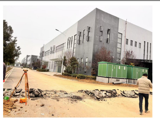
污水站周边企业现状
