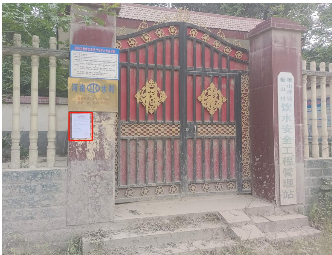
图 3.3-4 第二次公示现场照片——板山村饮水安全工程管理站
